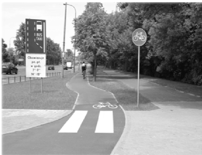
Ryc.1. Wydzielona ścieżka rowerowa jednokierunkowa, nawierzchnia asfaltowa w terenie zabudowanym.
