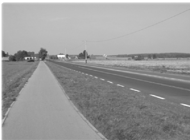
Ryc. 2. Adaptacja pobocza, ścieżka rowerowa dwukierunkowa, nawierzchnia asfaltowa w terenie niezabudowanym.
