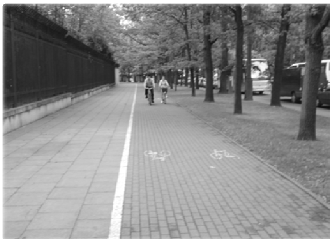
Ryc. 3. Ciąg pieszo – rowerowy, nawierzchnia z kostki betonowej w terenie zabudowanym.
