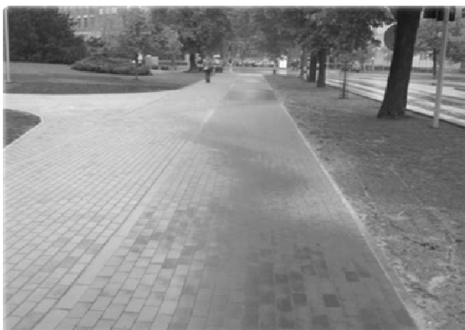
Ryc. 4. Ciąg pieszo – rowerowy, nawierzchnia z kostki betonowej w terenie zabudowanym.
